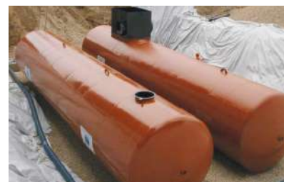
Citernes 100 m³ DN 3000 connectées ensemble par le bas
